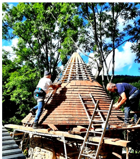
Chaque tuile est vissée sur la latte.
